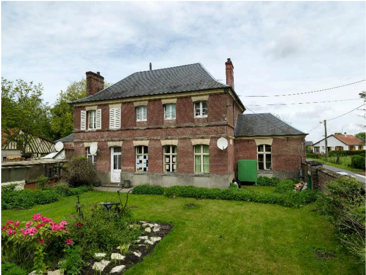
Vue de l'élévation sud et du jardin.
