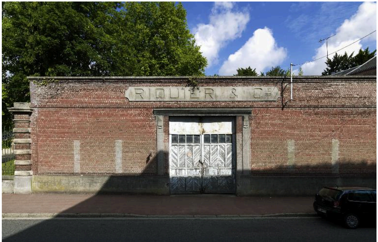
Ancien entrepôt, rue Roger-Salengro.
