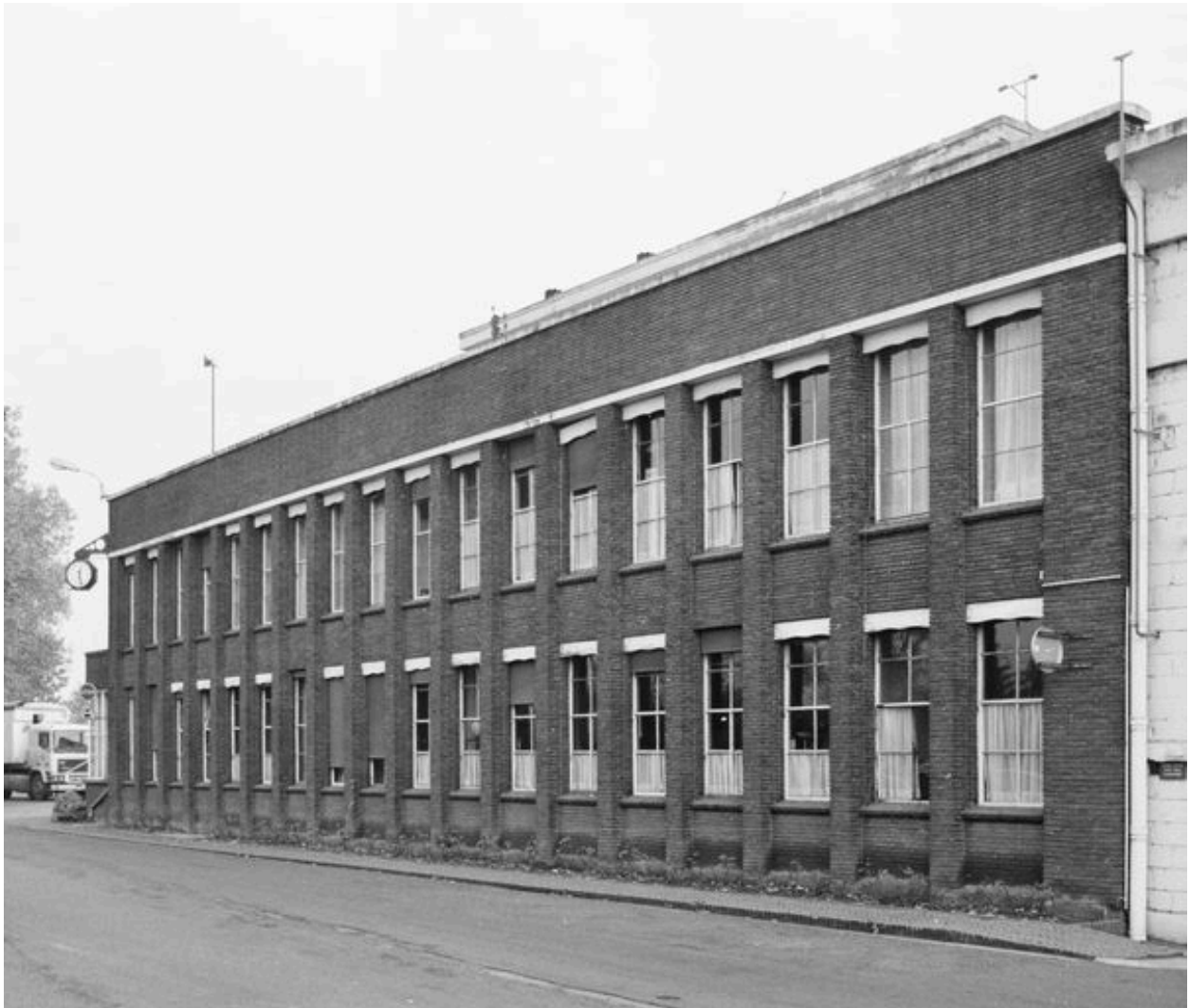
Bureau : élévation antérieure.
