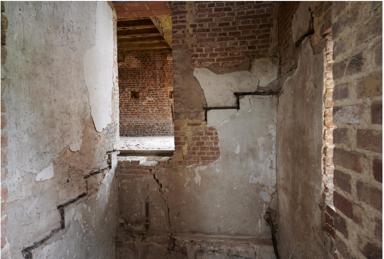
Premier étage. Logis du XVI e siècle. Ancienne cage d'escalier desservant les étages et la tour porche.
