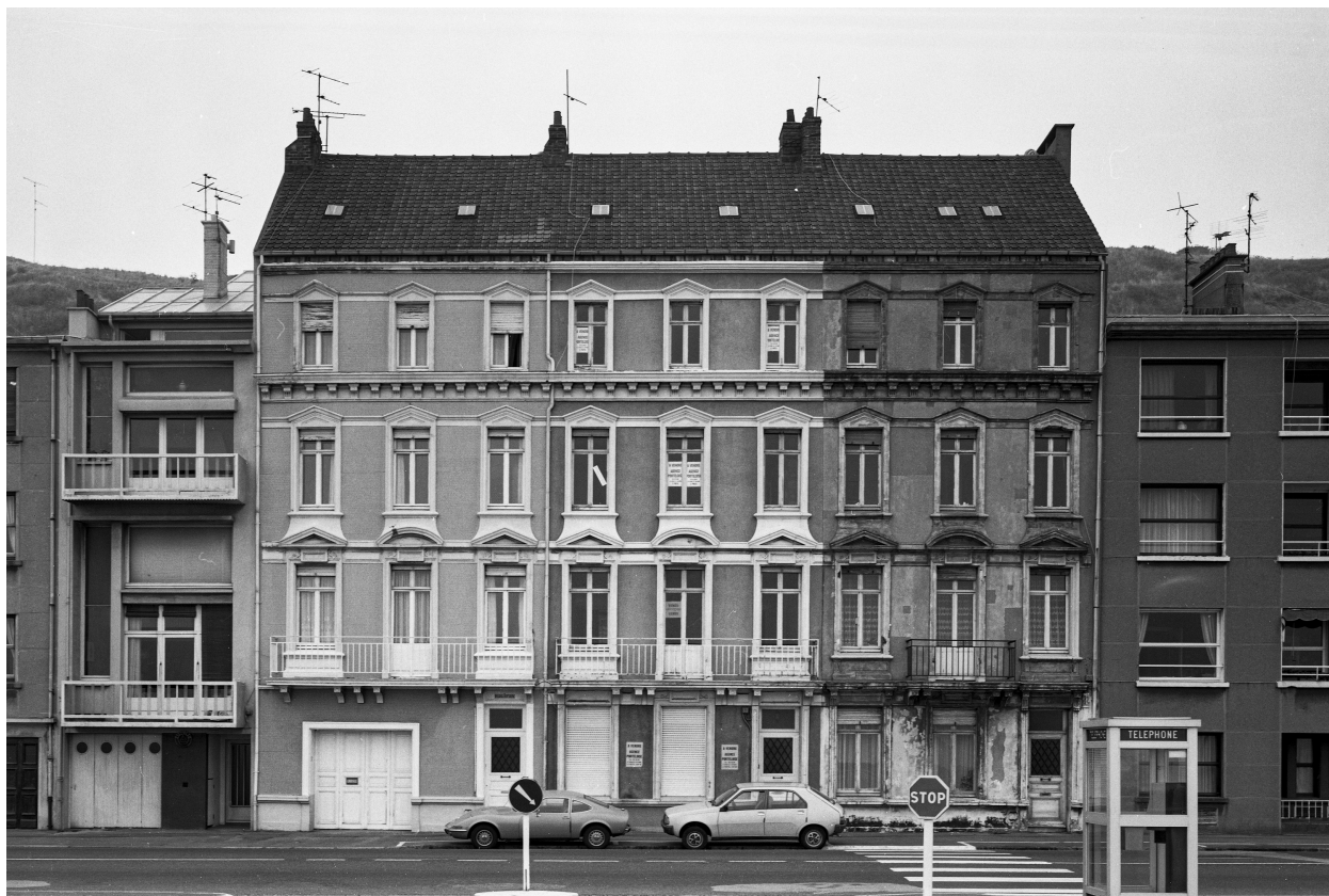
Vue d'ensemble sur voie.
