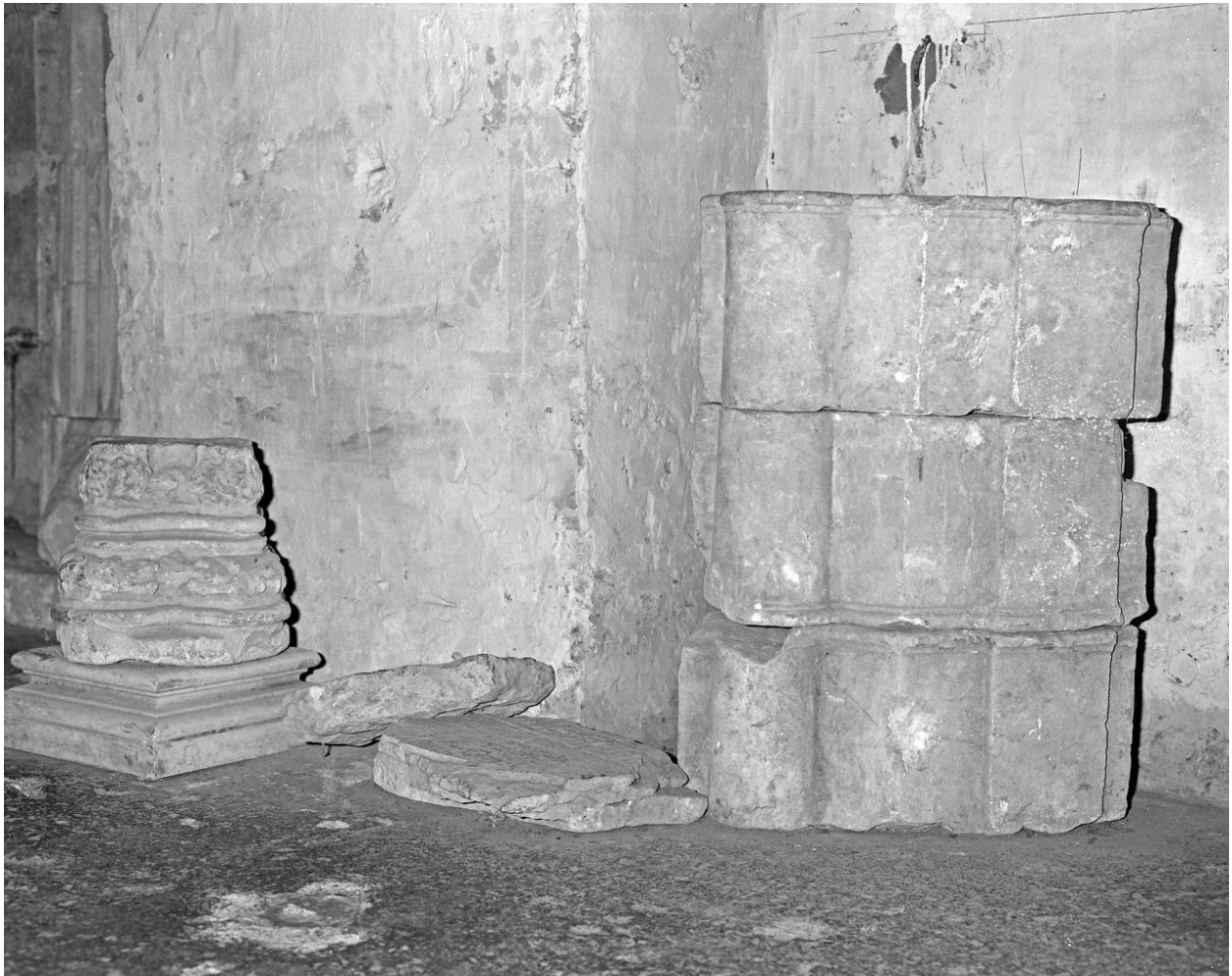
Vue d'ensemble des colonnes.
