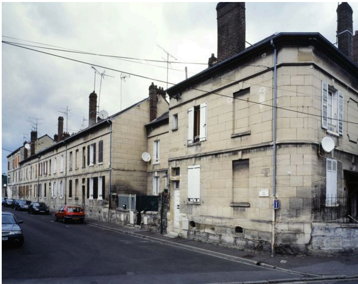
Les logements de la cité ouvrière Lucile depuis la rue des Usines.
