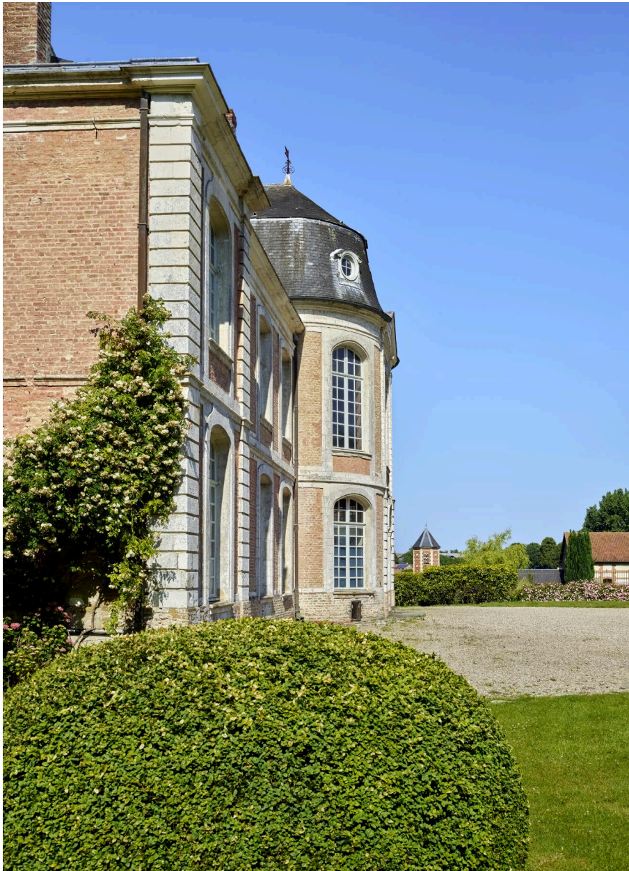
Façade nord avec le détail de l'avant-corps central vue depuis l'est.
