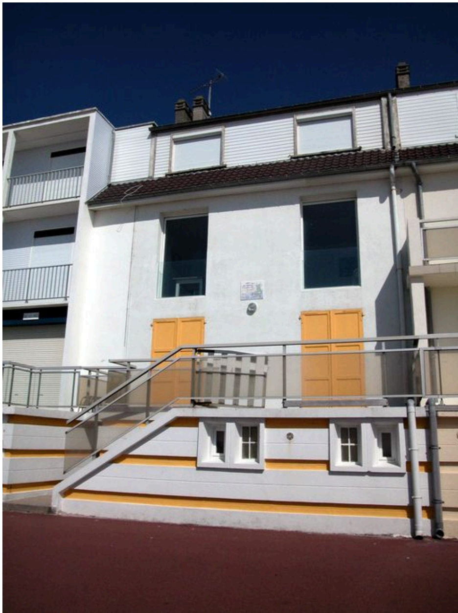
306 boulevard maritime sud (Clair de Lune), façade sur mer.
