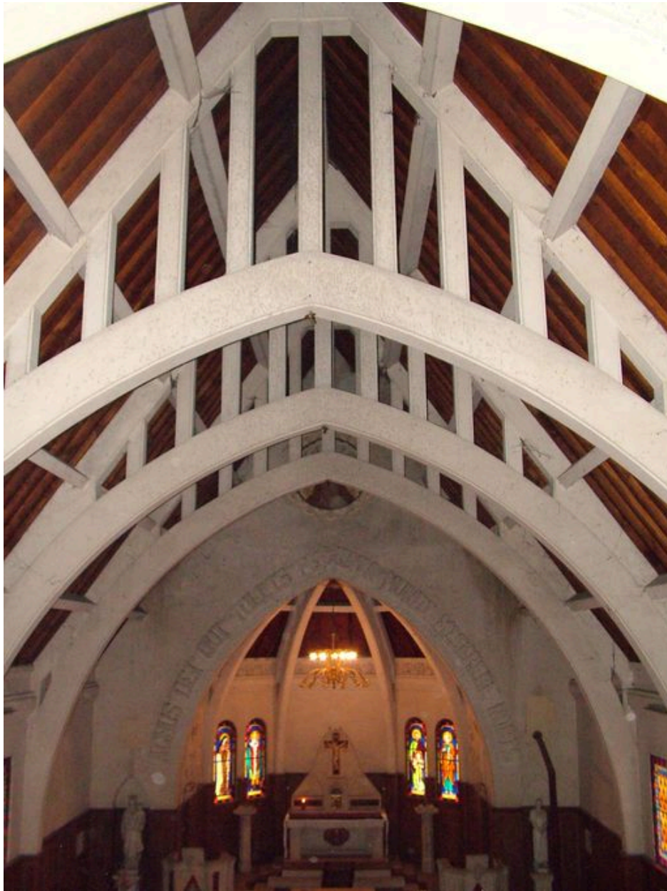
Détail de la charpente.
