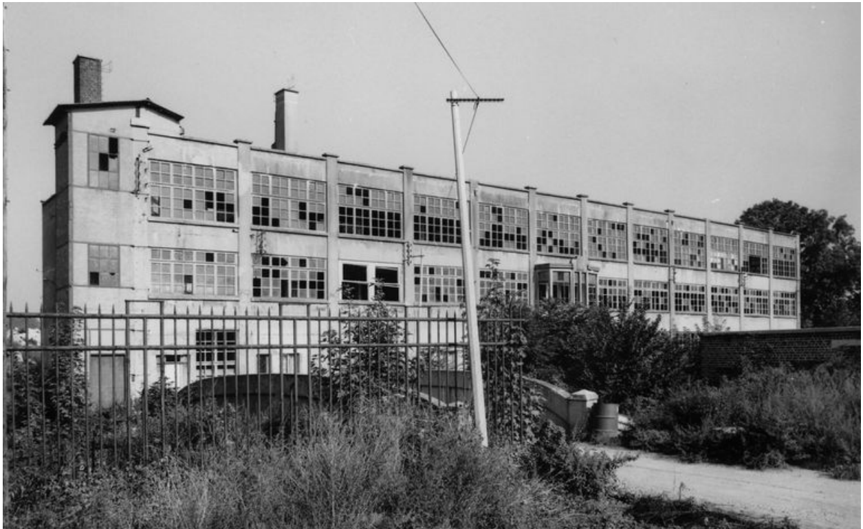
Atelier de fabrication (tissage), élévation est.
