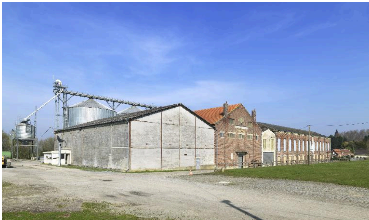
Vue d'ensemble des ateliers de fabrication, vue de trois-quarts.
