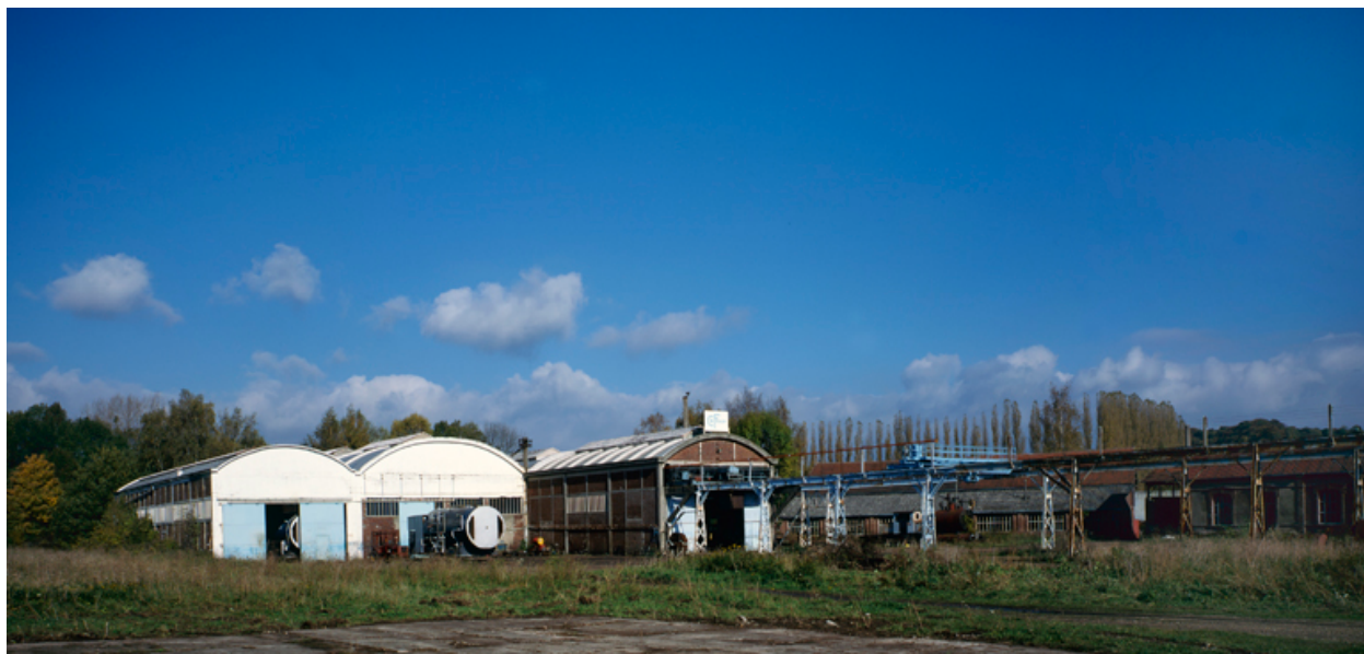
Vue d'ensemble sud-ouest des ateliers de chaudronnerie construits en 1920 et du transporteur aérien.
