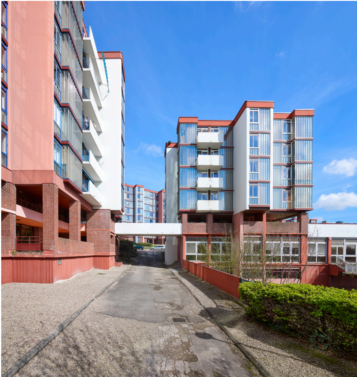
Passage et passerelle entre les bâtiments G1 et G2, vue depuis le sud.
