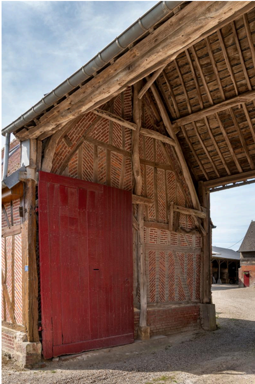
Détail de la mise en œuvre de la charpente de l'entrée charretière, n°10 rue Tassart.
