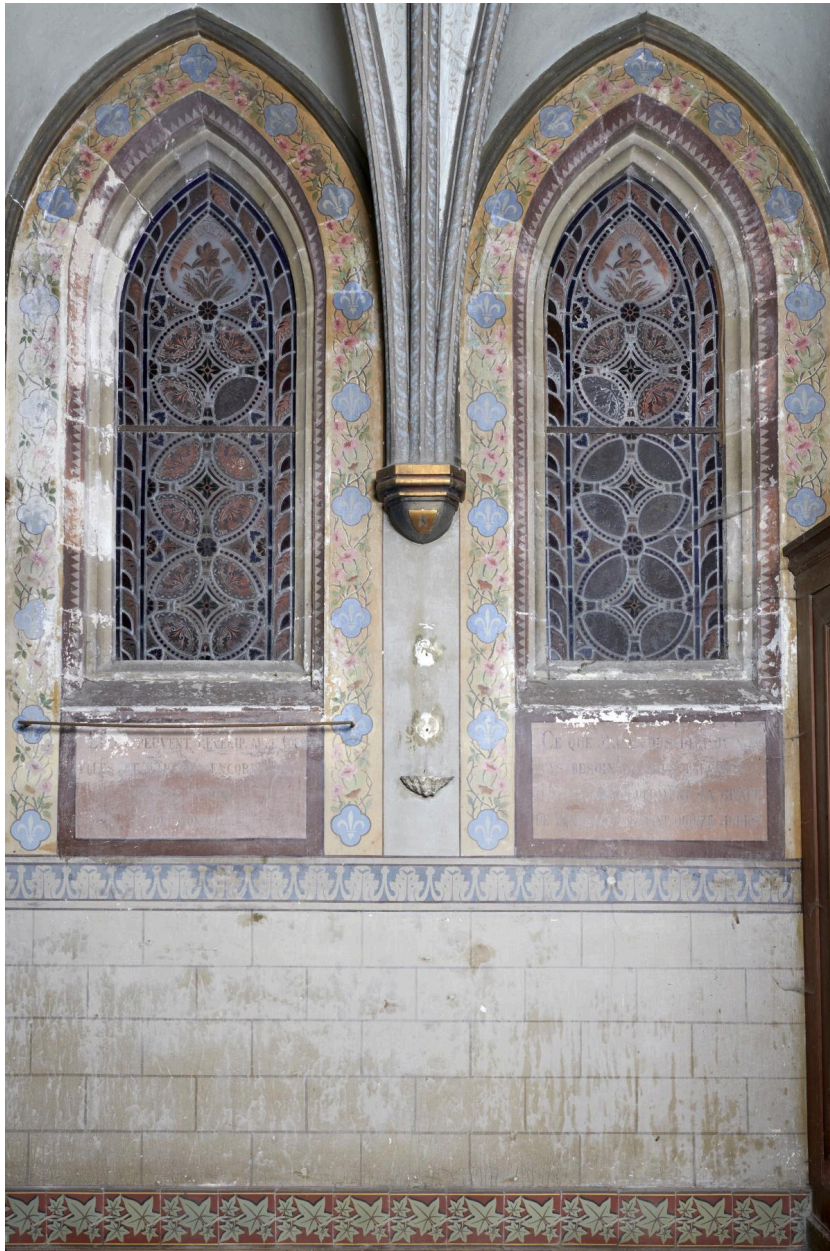
Détail des baies et vitraux situées à droite (est).
