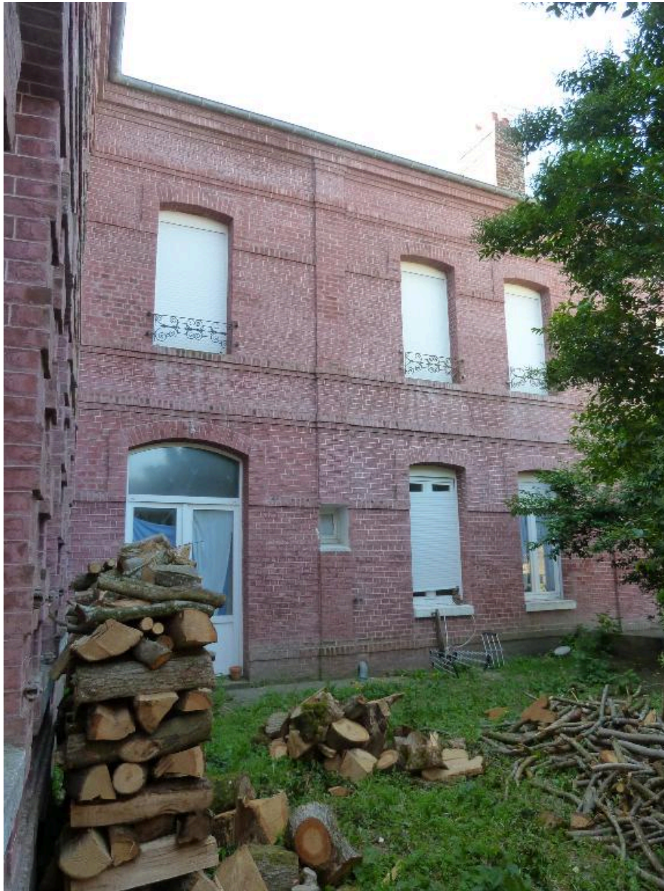
Les anciens ateliers de fabrication.
