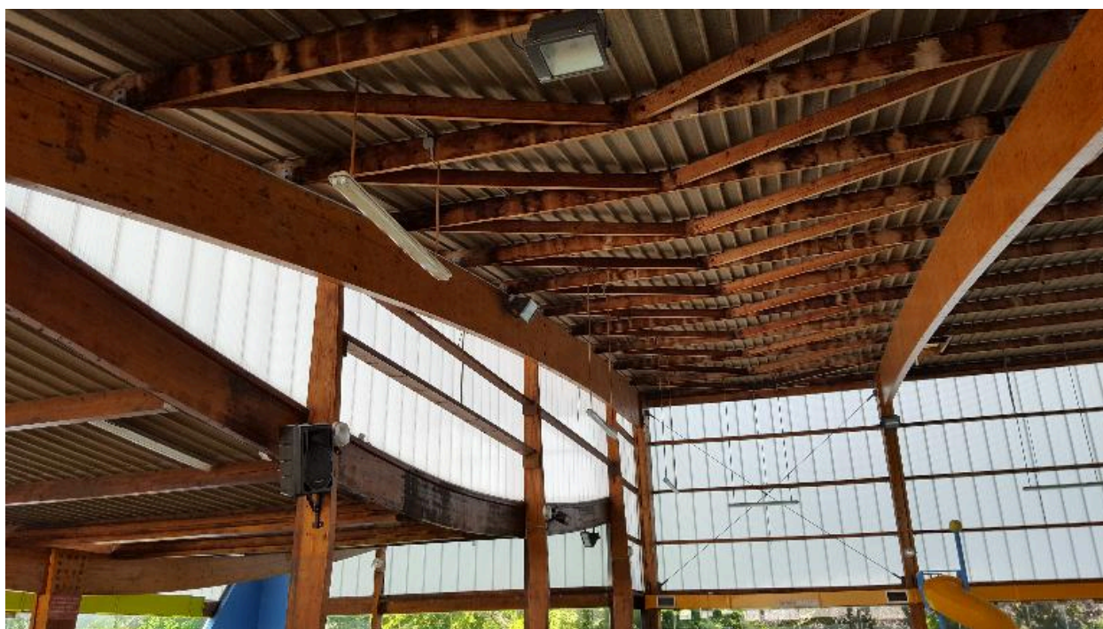
Détail de la charpente.
