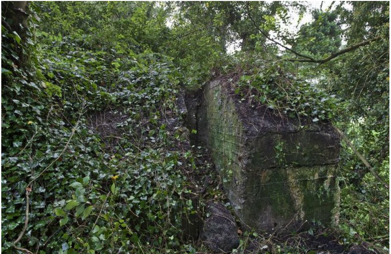
Élévation Nord. Détail de l'empreinte d'un ancien mur de brique
