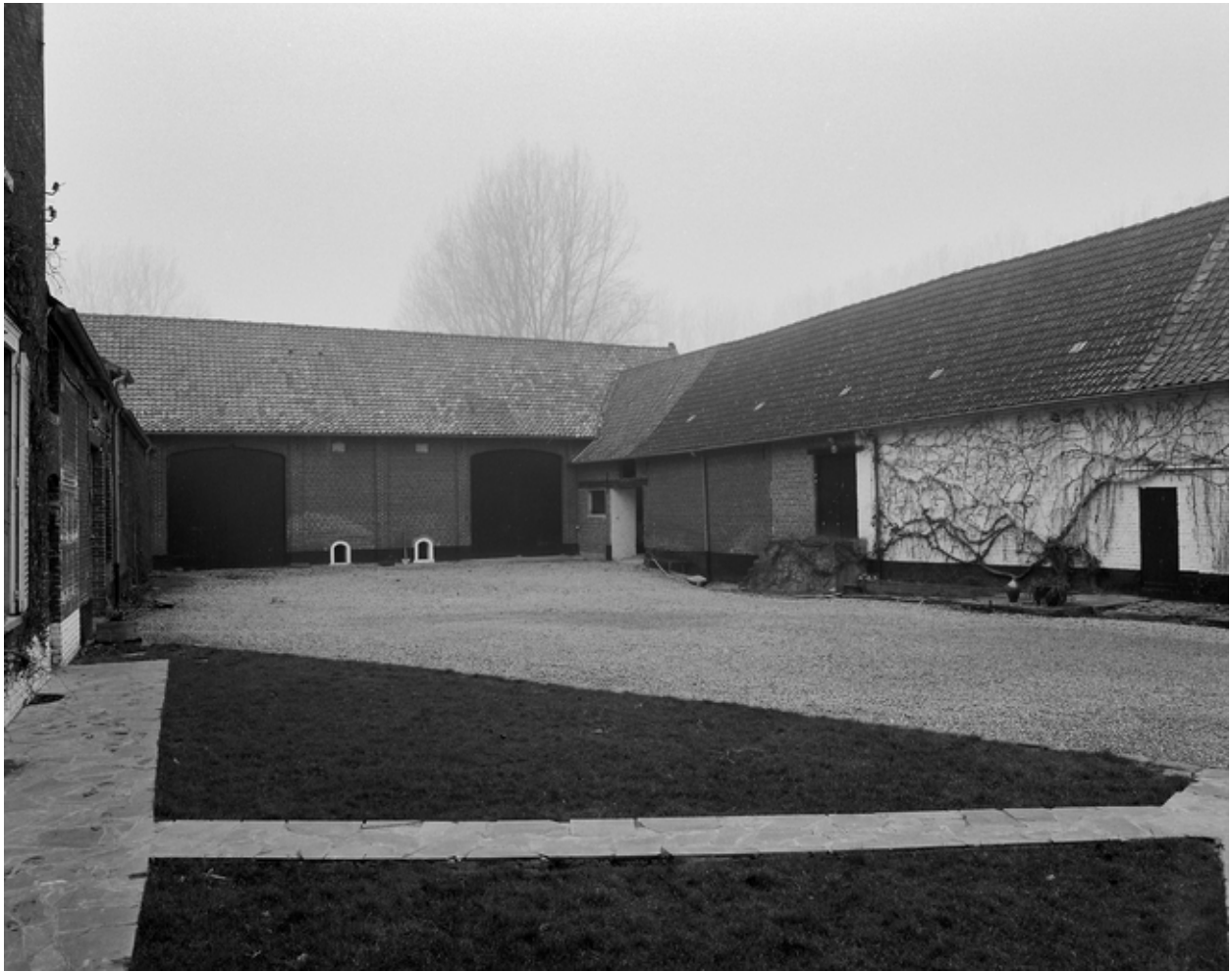
Grange, étables, écuries et porcherie, façades sur cour.
