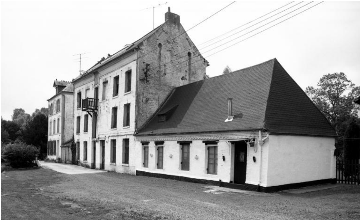
Vue d'ensemble de l'élévation sur cour de l'habitation, du bâtiment d'eau et de la boulangerie.
