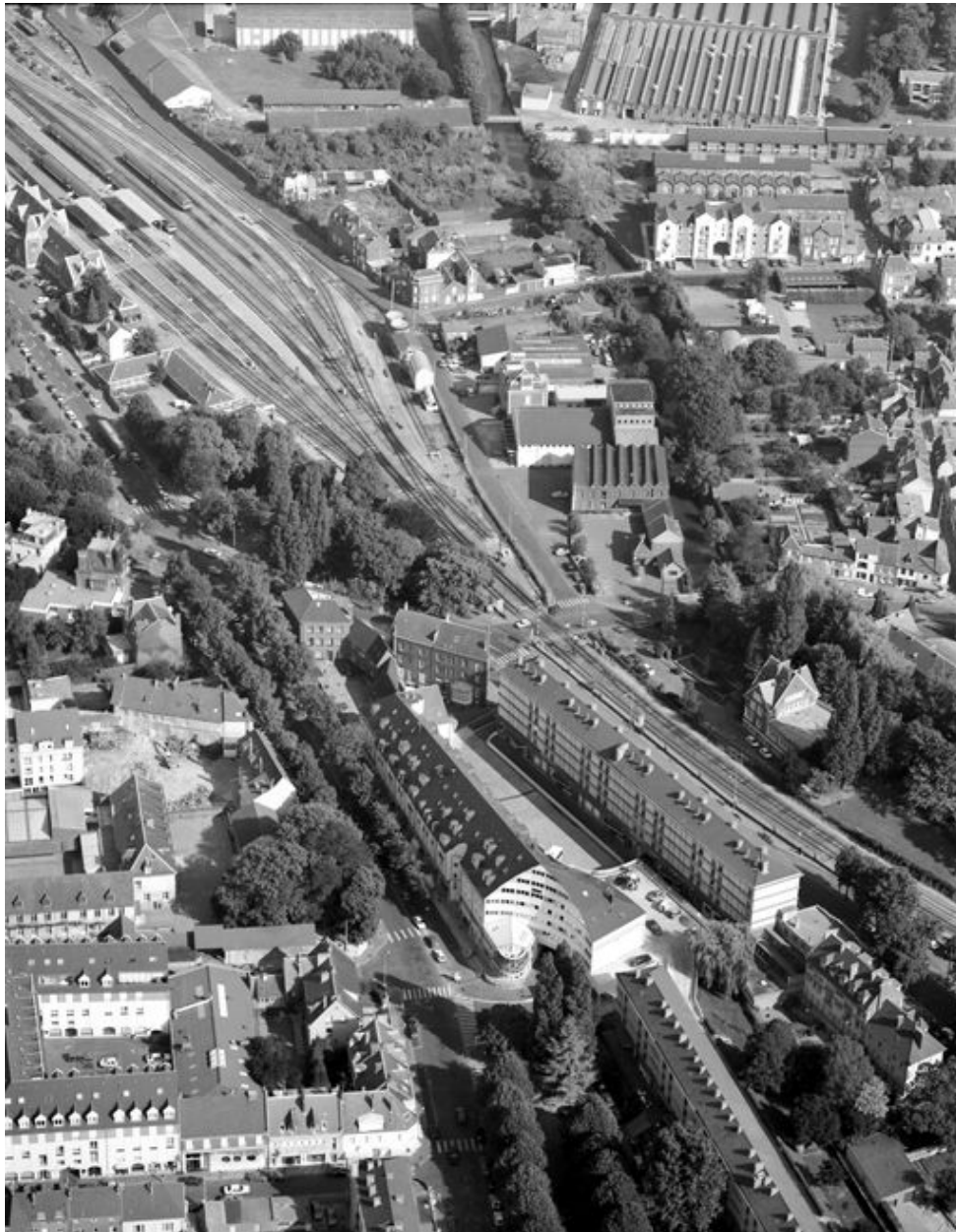
Vue aérienne de l'usine en 1994.
