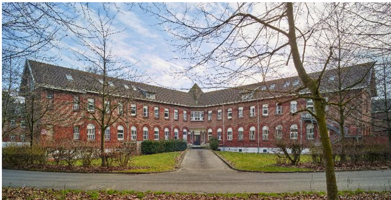
Bâtiment d'hospitalisation dit pavillon G8, de configuration en Y, élévation postérieure, vue générale prise de face.
