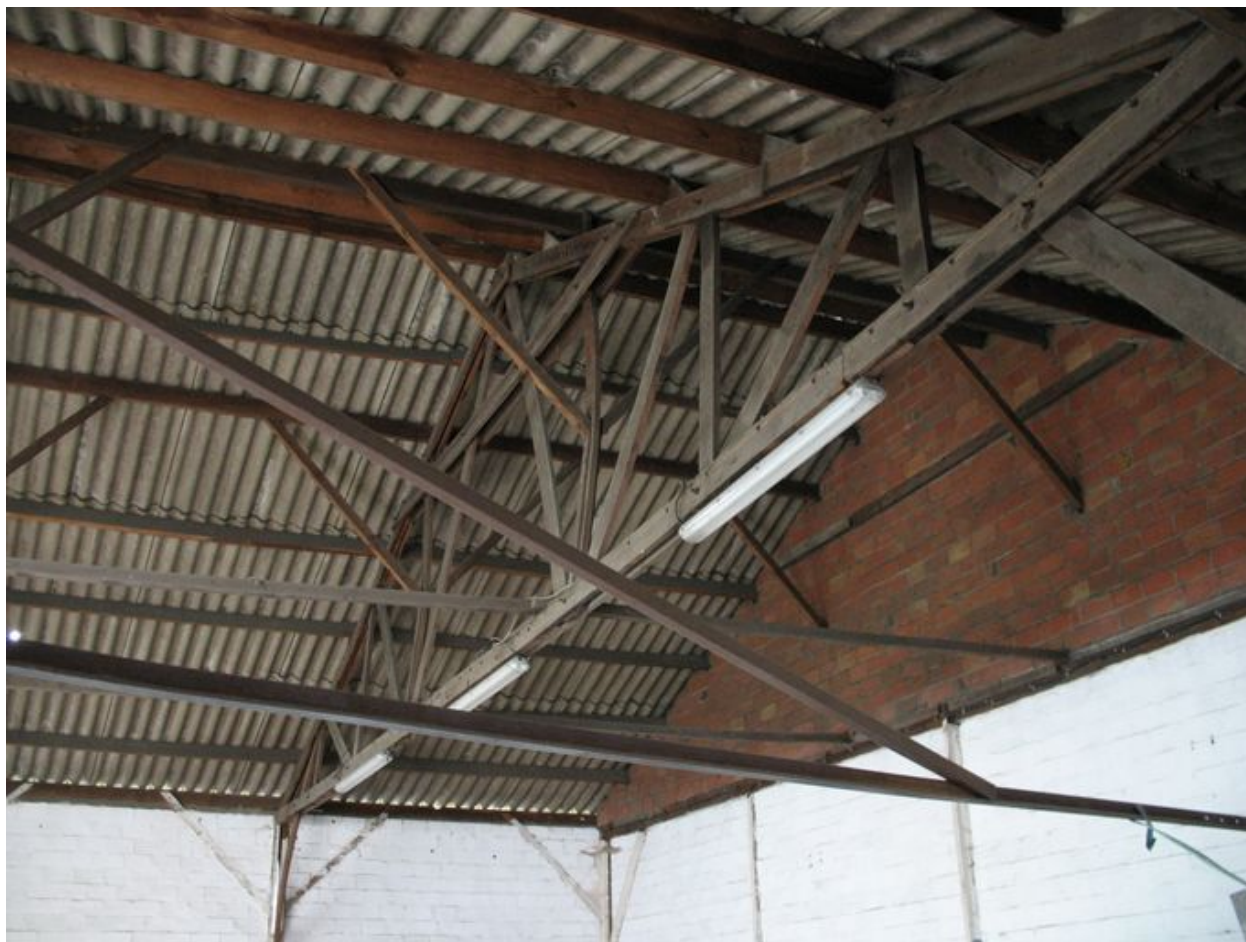
Détail de la charpente en bois du magasin de stock des fûts.
