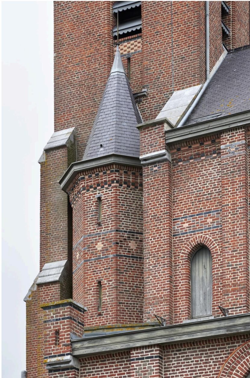
Détails du 1er niveau dont tourelle d'escalier et porte d'accès au toit.
