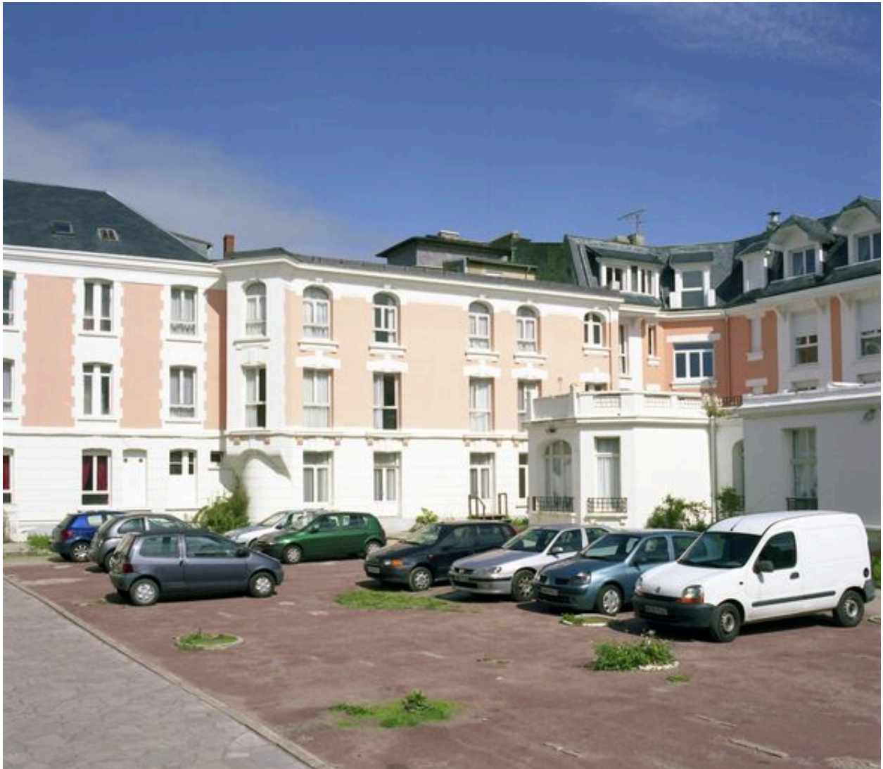
Corps de logis donnant sur la rue de Lhomel, élévation postérieure.
