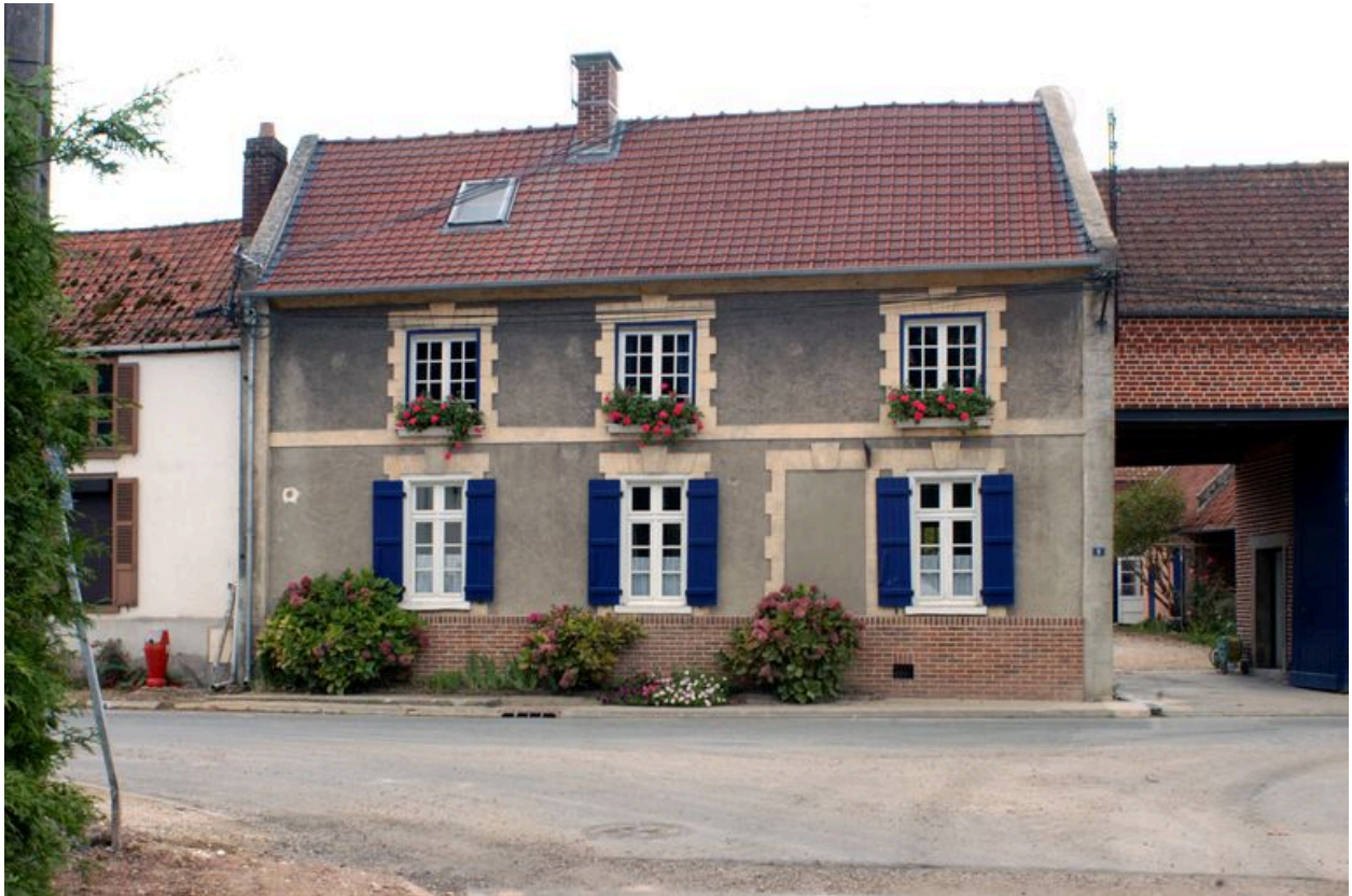
Ancienne maison à boutique, 9 rue Paul-Baroux.
