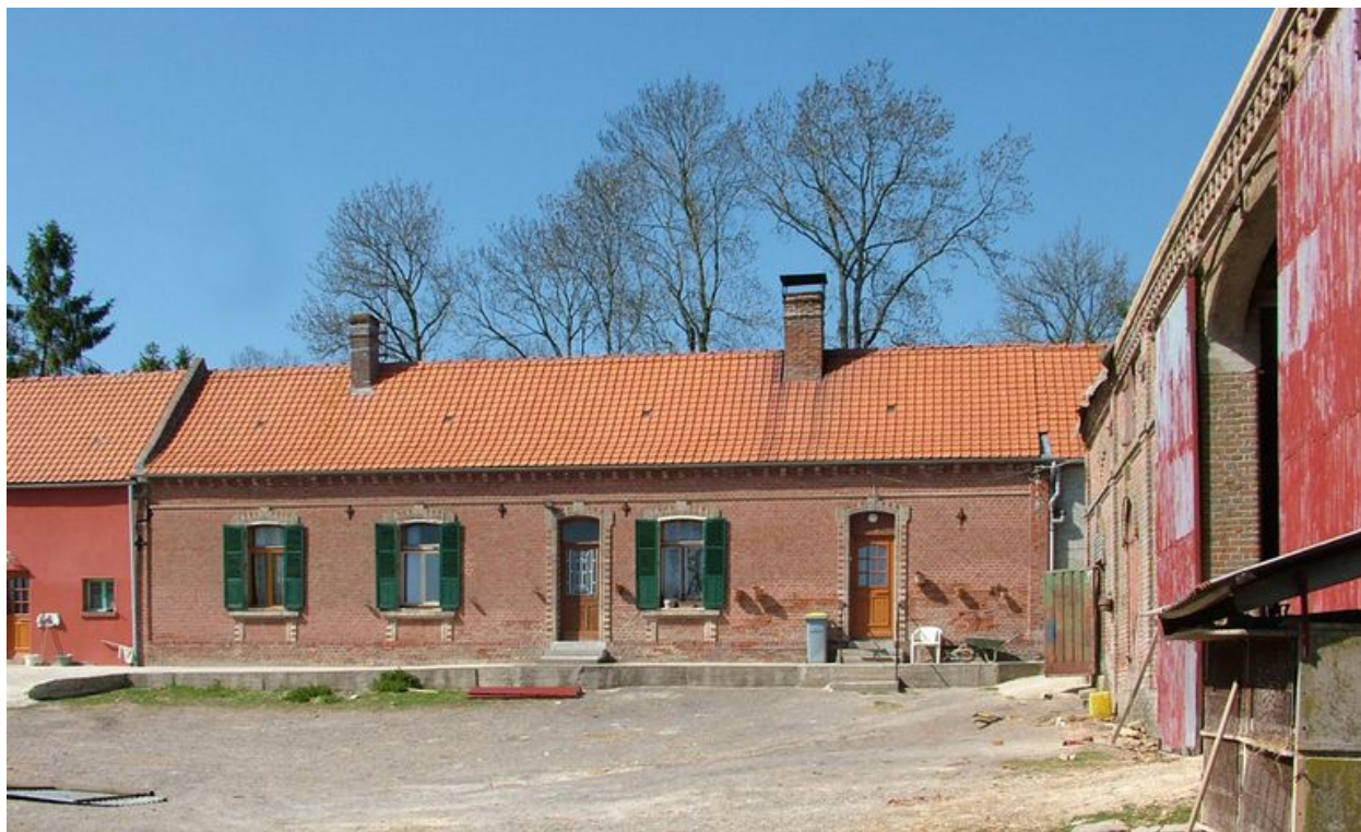
Logis de fond de cour et grange.
