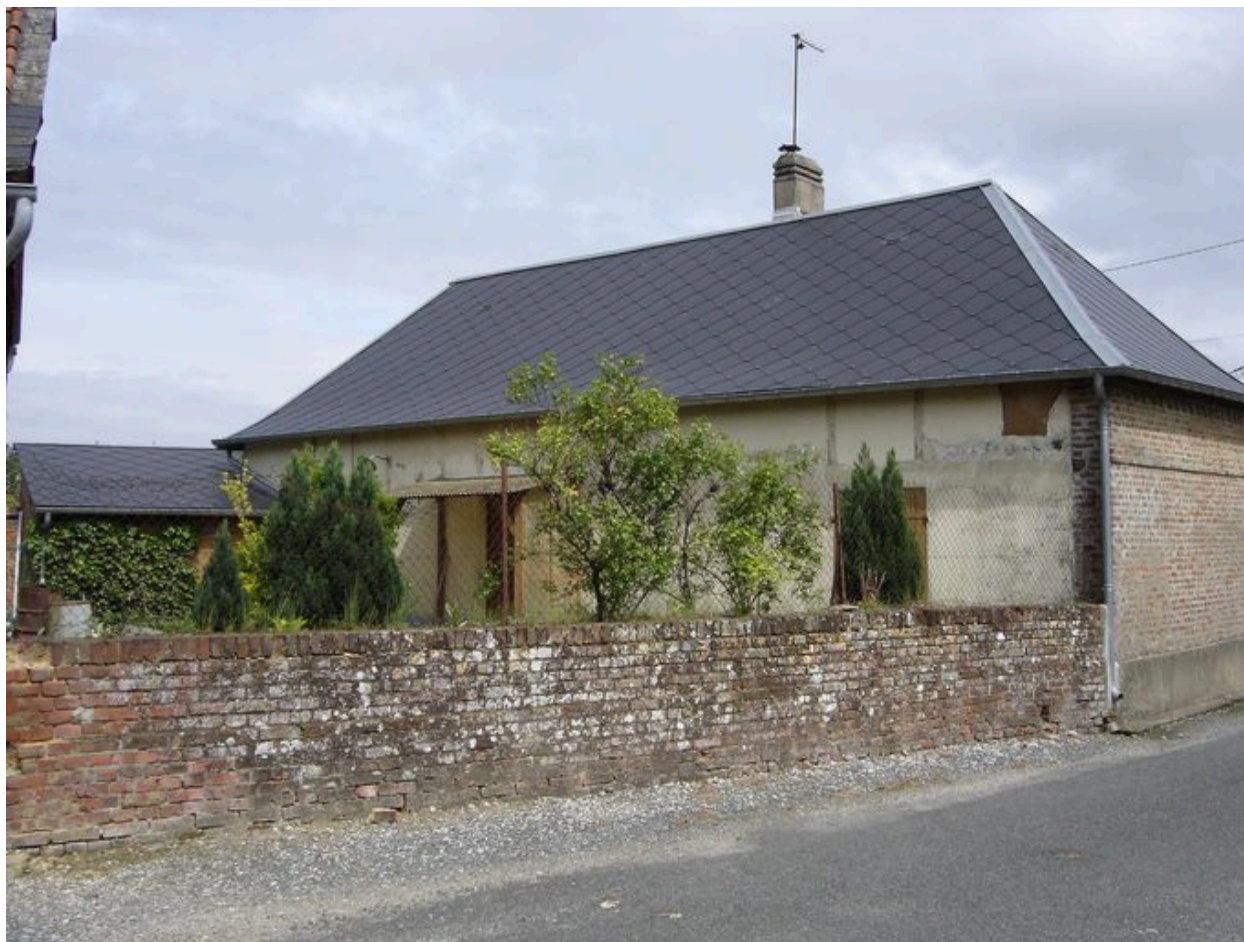
Vue postérieure du logis.
