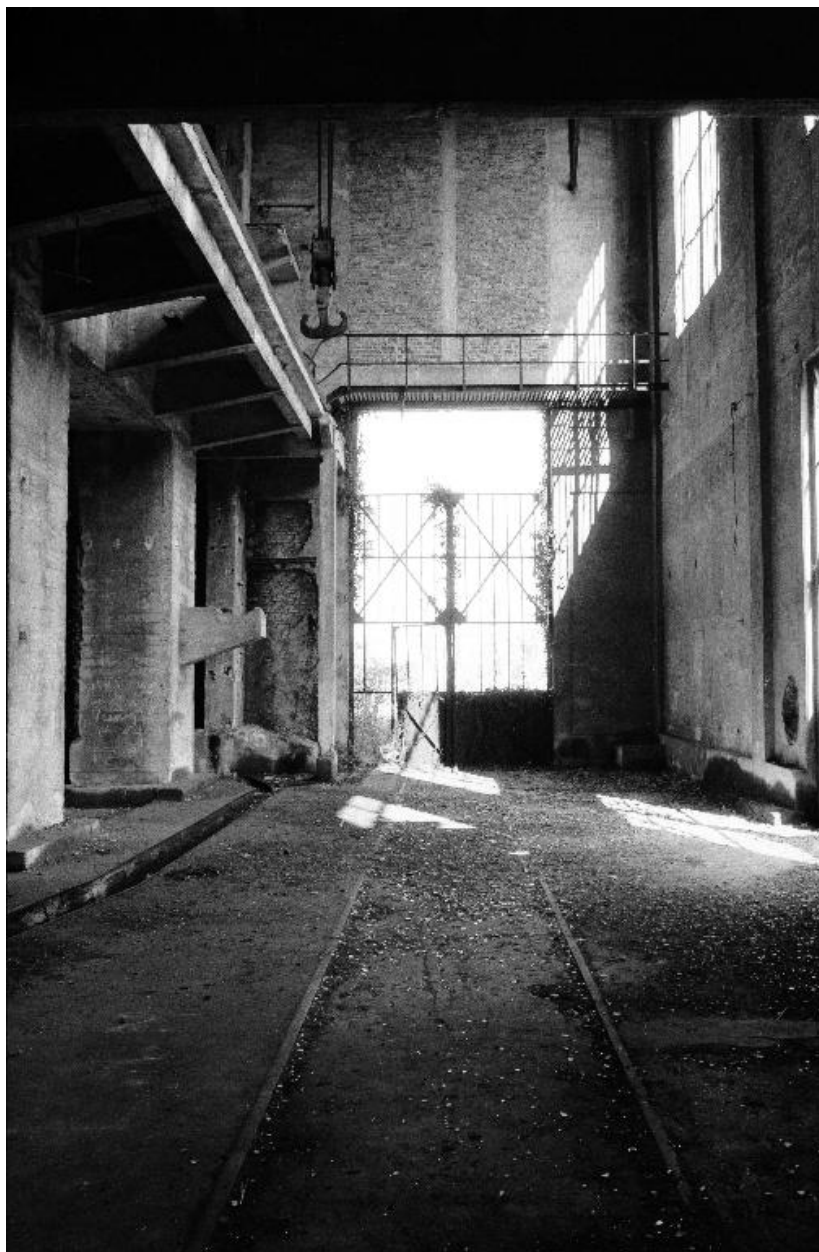
Intérieur, vue générale.
