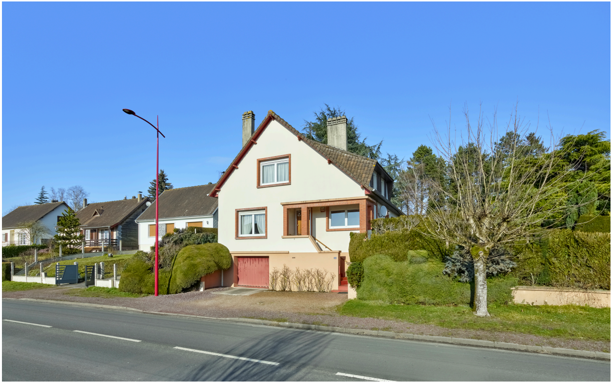
Maison, depuis le sud.
