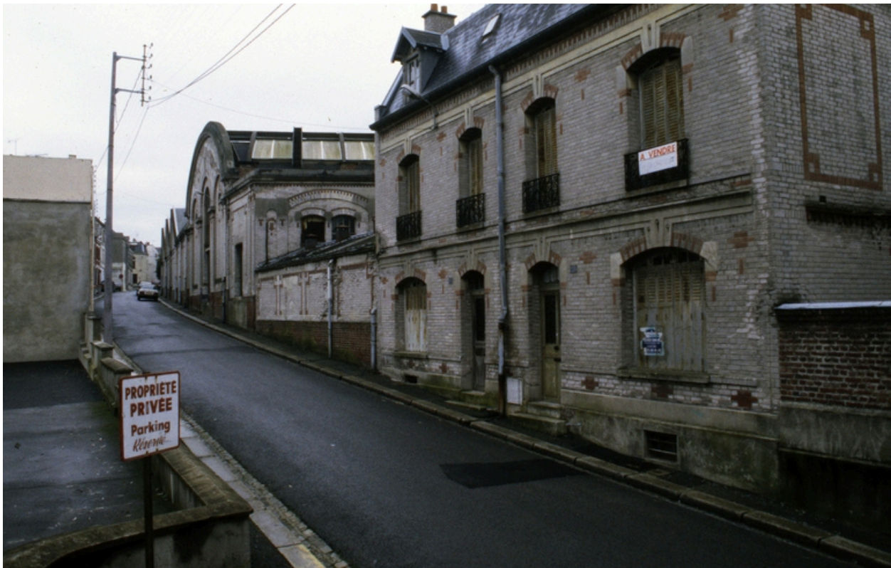
L'usine vue depuis la rue de la Grange, 2001.
