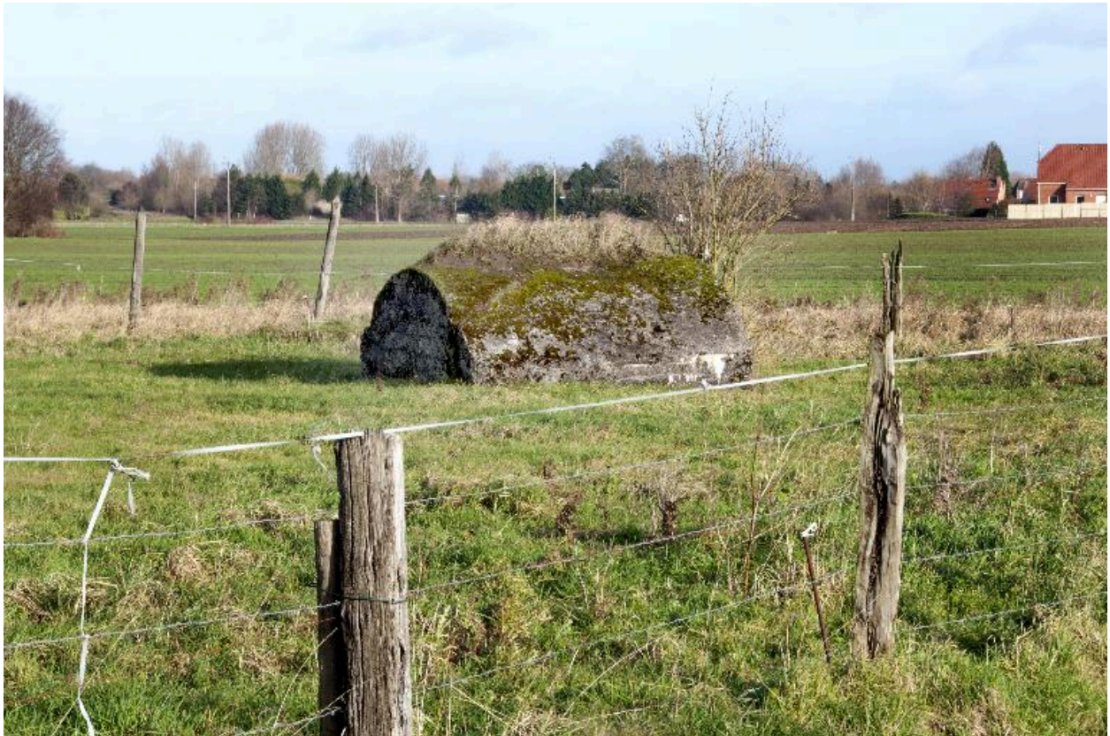
casemate j, vers le nord-est
