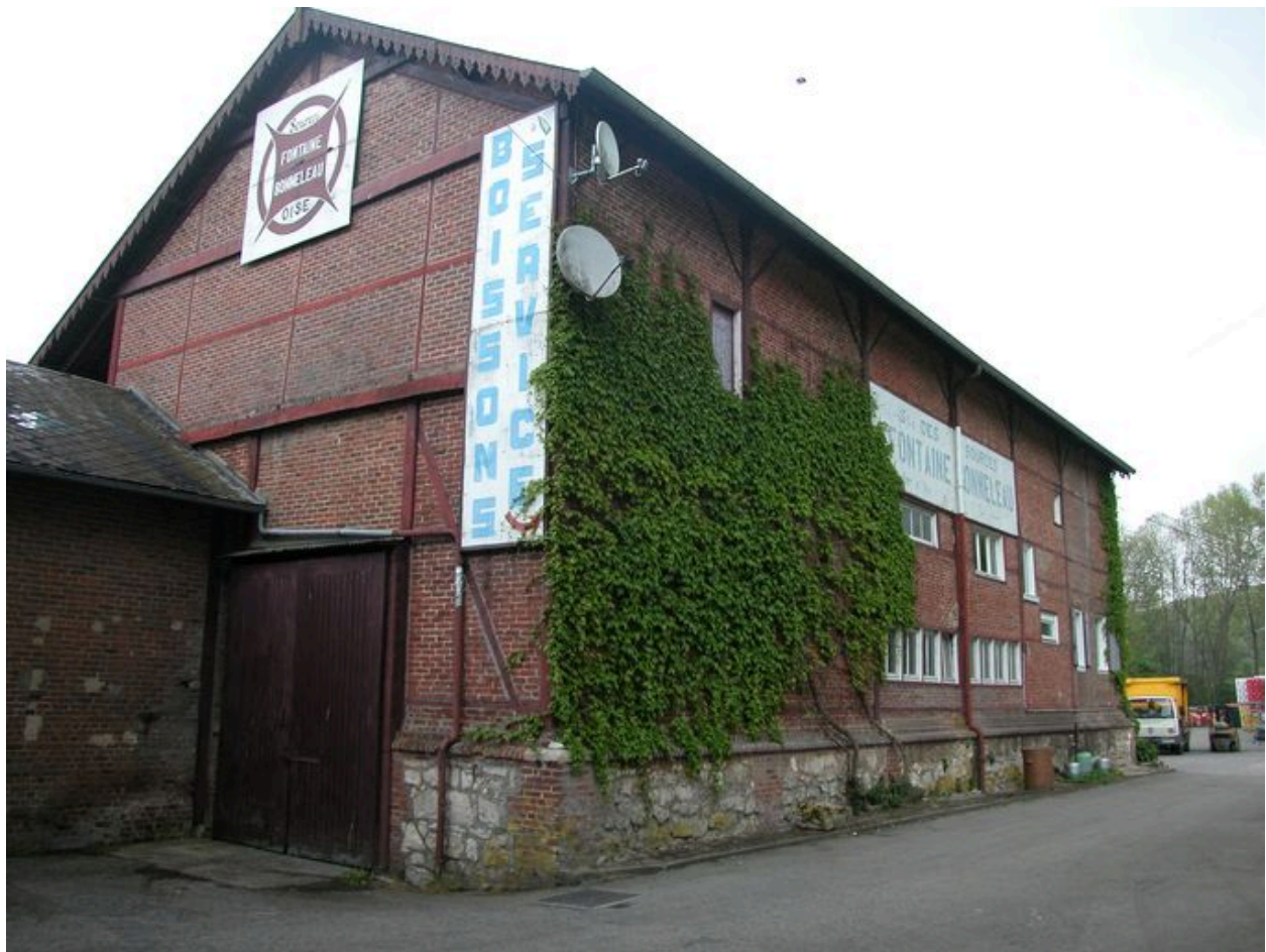
Vue d'ensemble de l'atelier de conditionnement.
