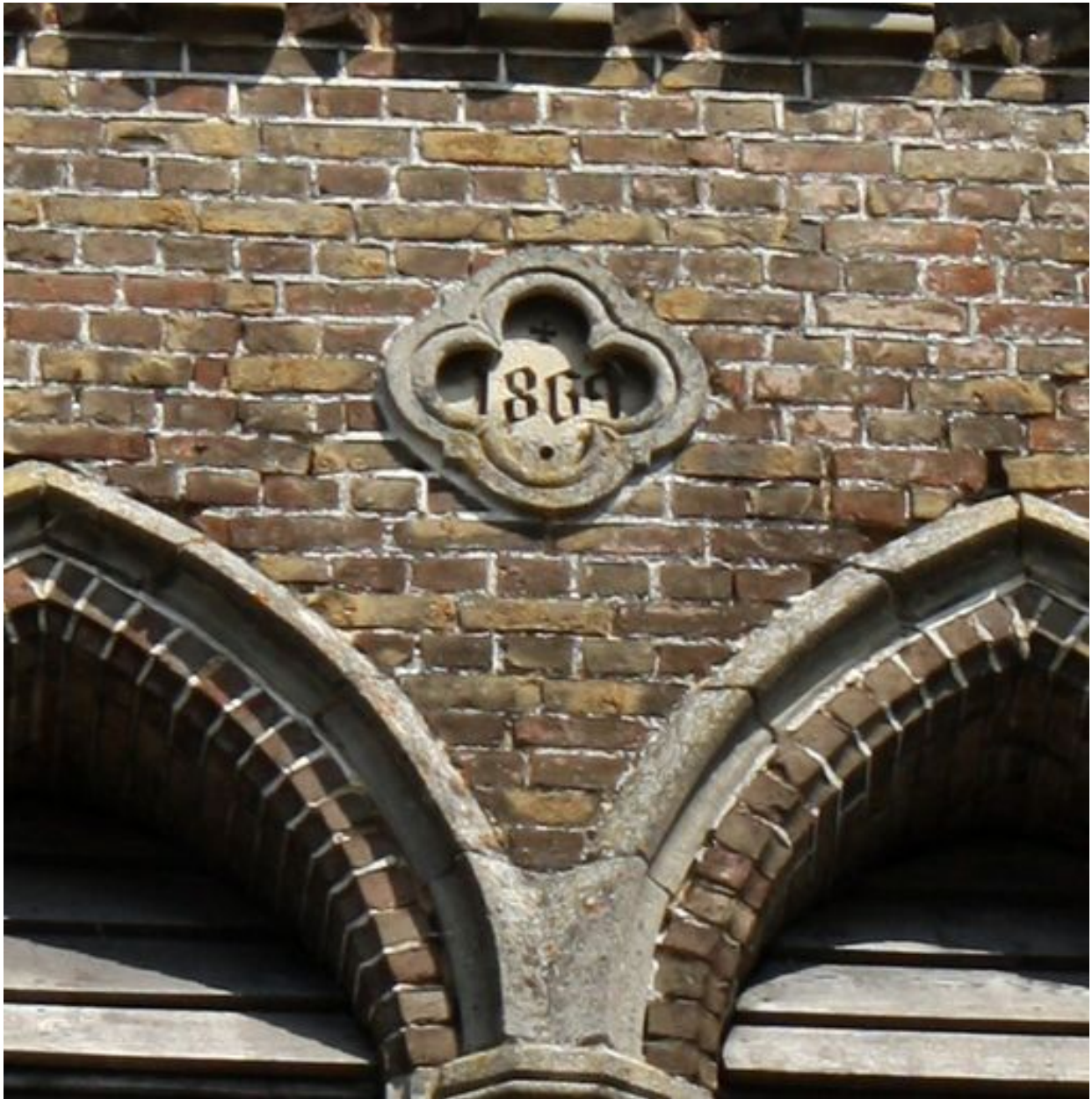
Détail du quadrilobe portant la date de 1869, au sommet du clocher.
