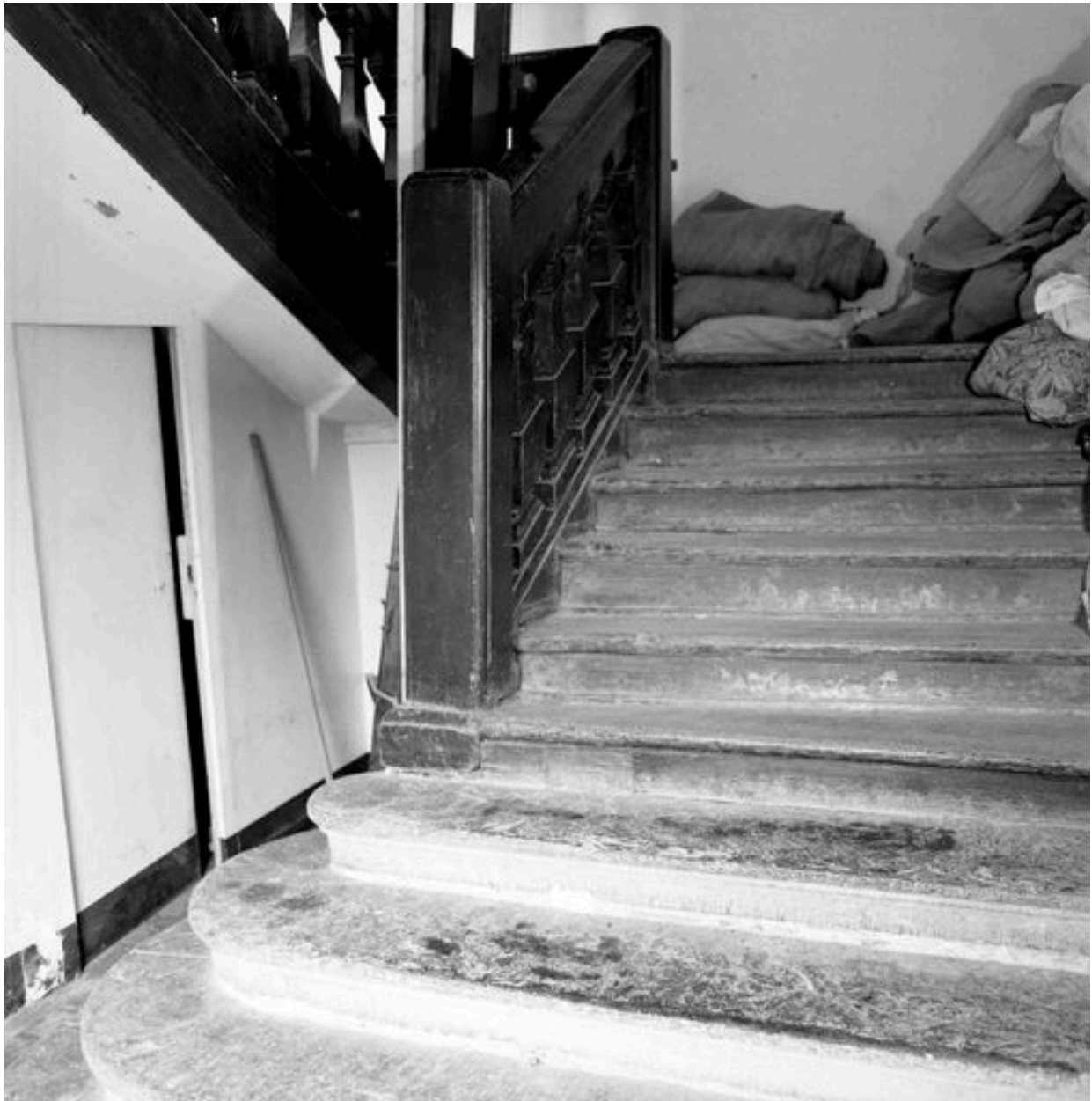
Aile de la rue de la Cavalerie : n° 35-37, escalier "de Louis XIV" desservant actuellement le 1er étage du corps de logis médiéval : rez-de-chaussée, 1ère volée.
