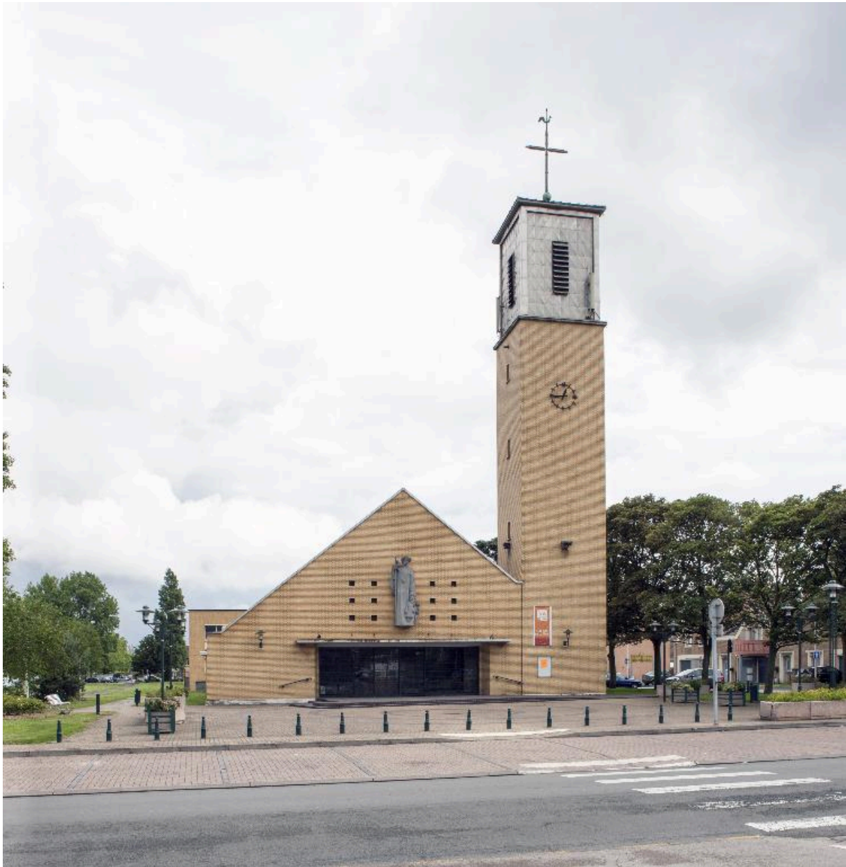
Vue générale de l'élévation antérieure de l'église avec son parvis.
