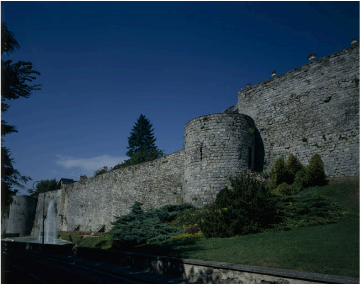
Vue générale de la muraille orientale depuis la rue de La Barre.
