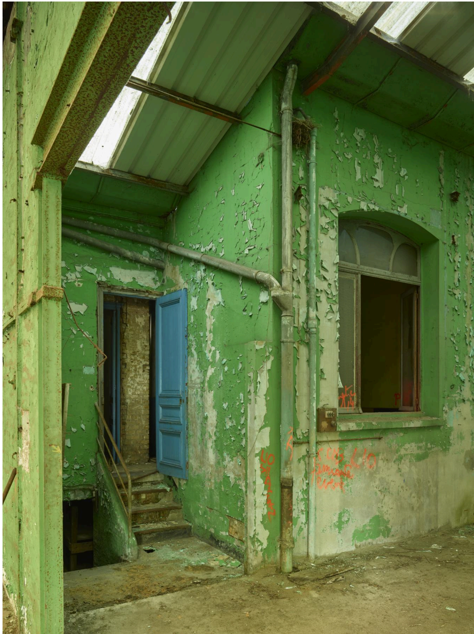
L'entrée des bureaux depuis l'atelier de fabrication ouvrant boulevard de la République.
