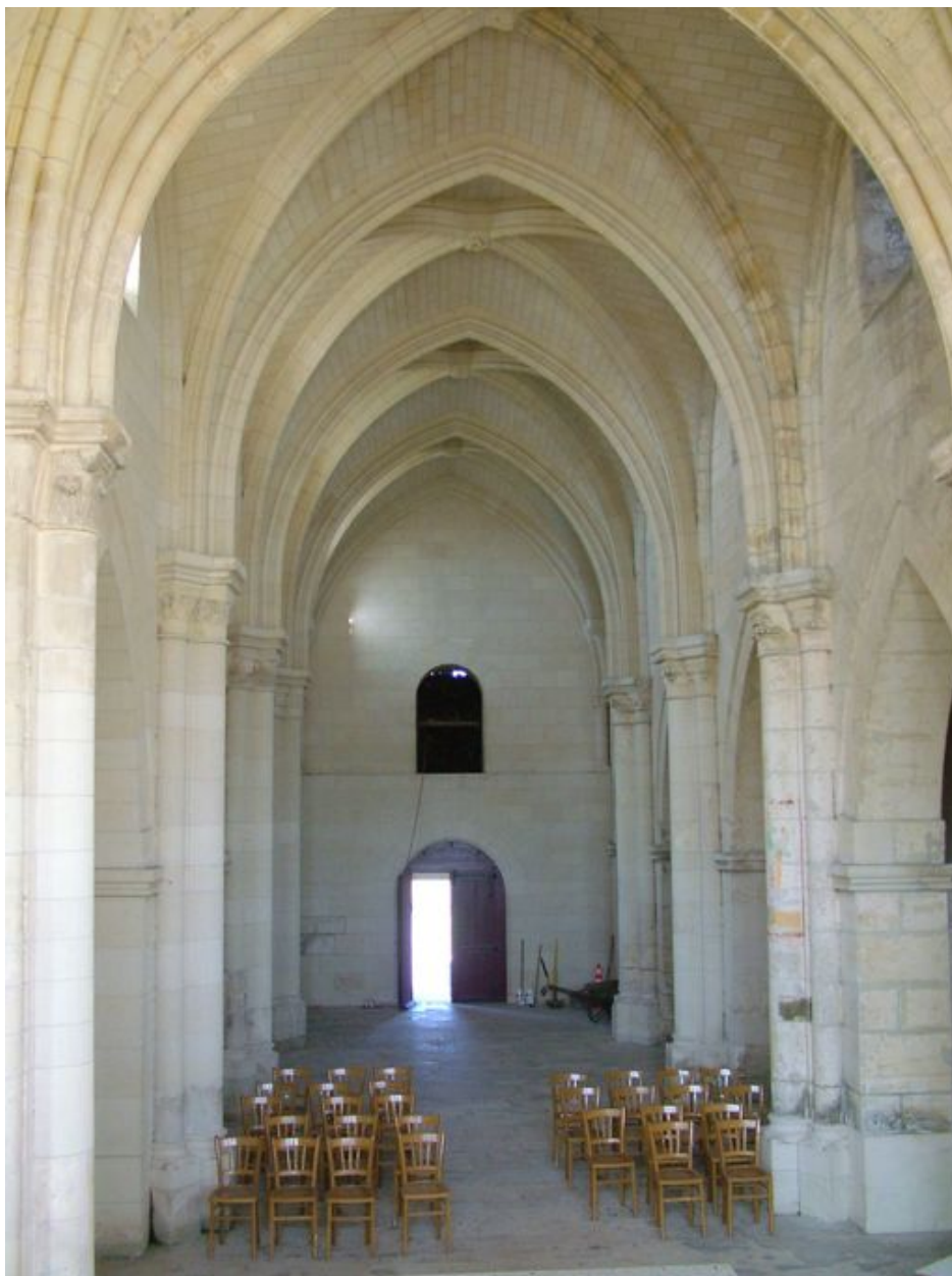
Vue intérieure de la nef.
