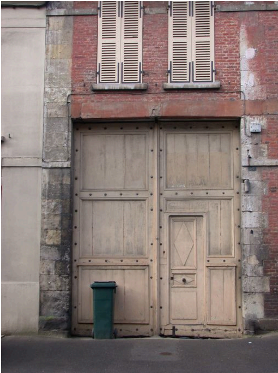
Détail du portail d'entrée de l'usine.
