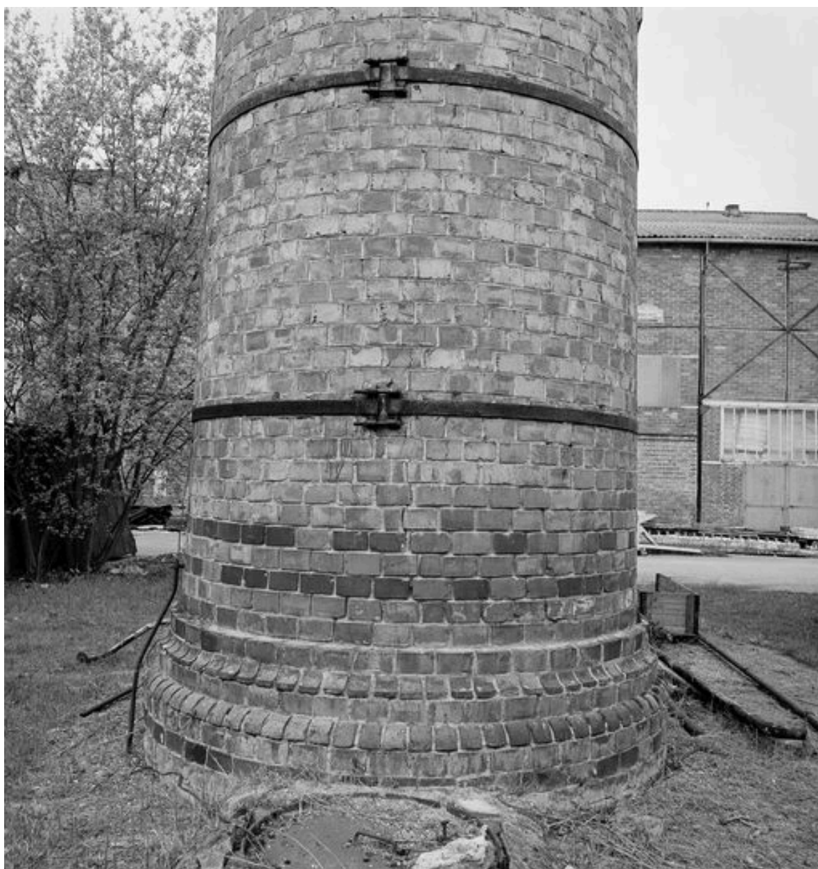
Socle de la cheminée d'usine.
