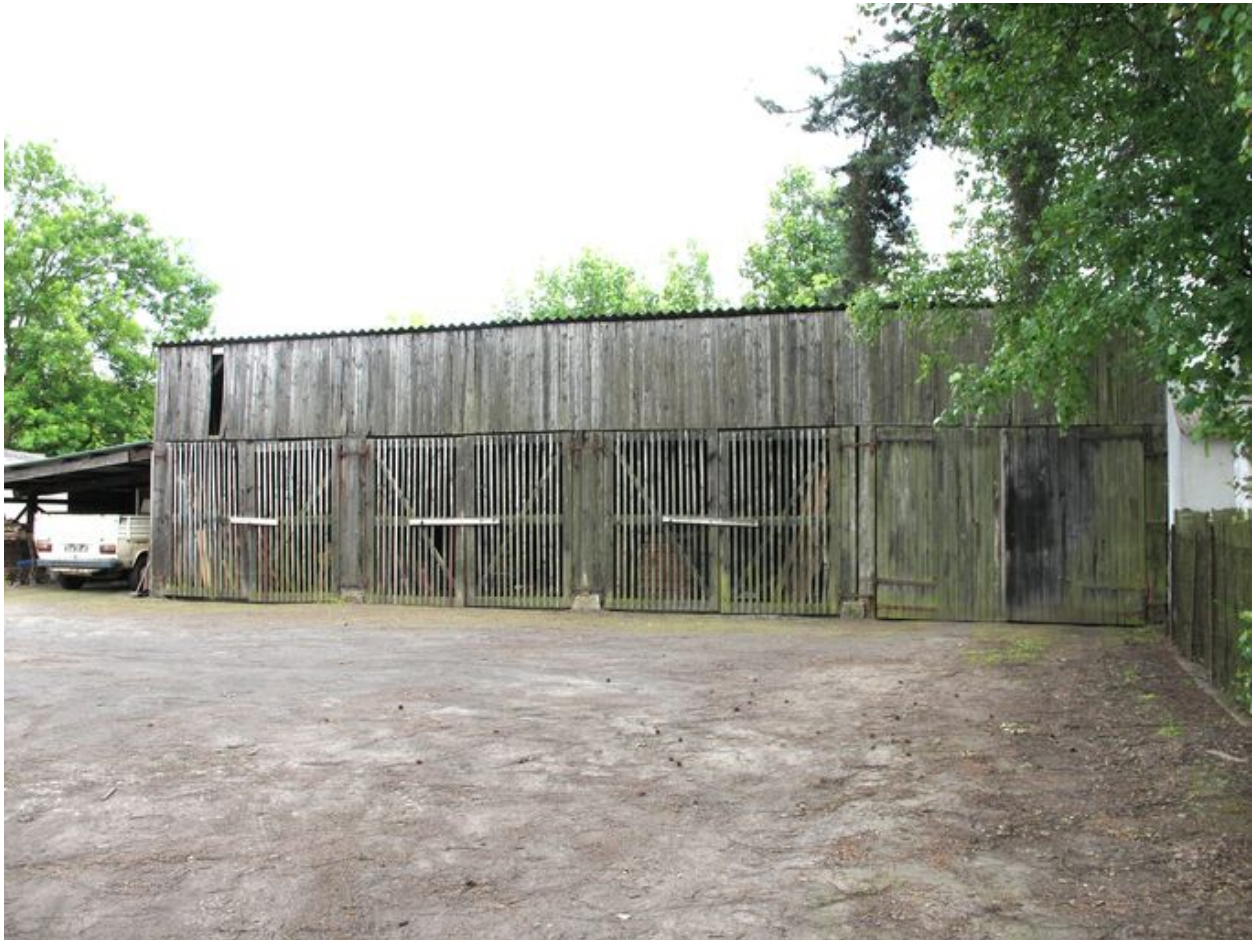
Hangar de stockage du bois.
