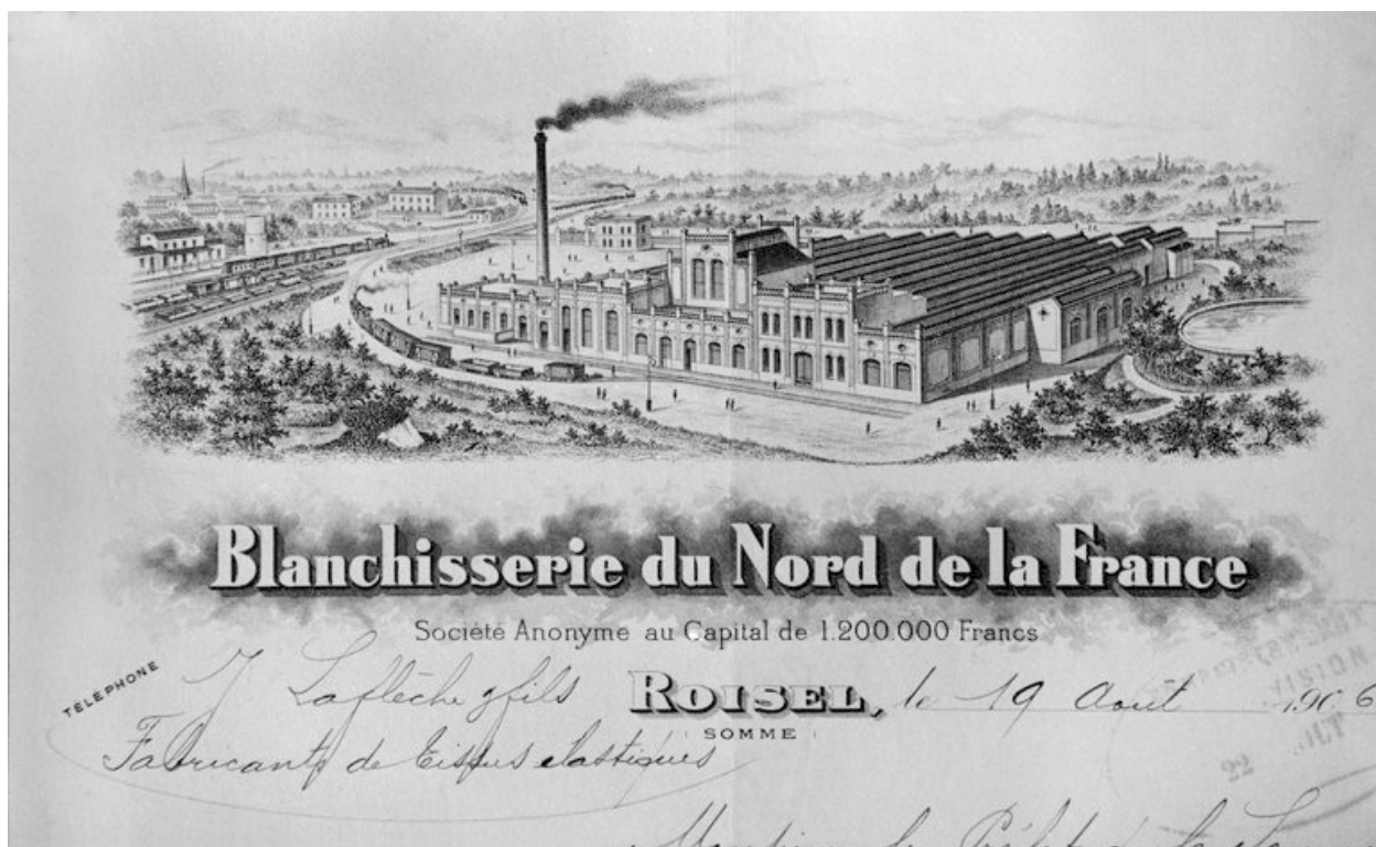
Vue cavalière de l'usine, vers 1900 (AD Somme ; M 96861).
