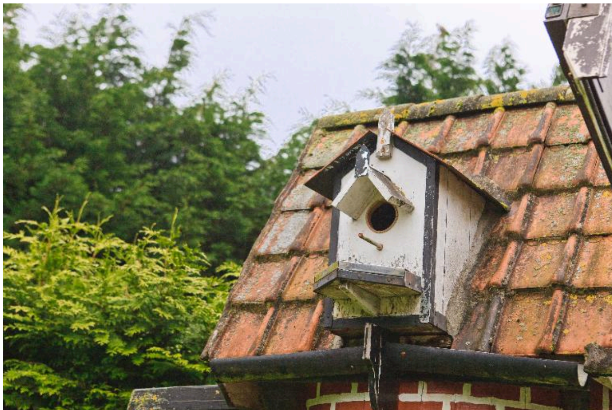
Moulin : détail de la toiture.
