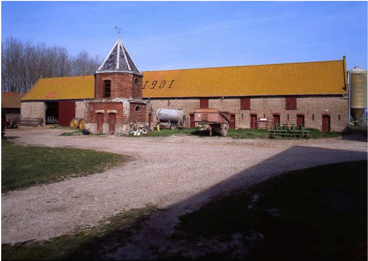
Vue des étables, de la grange et du pigeonnier situés au nord de la cour.
