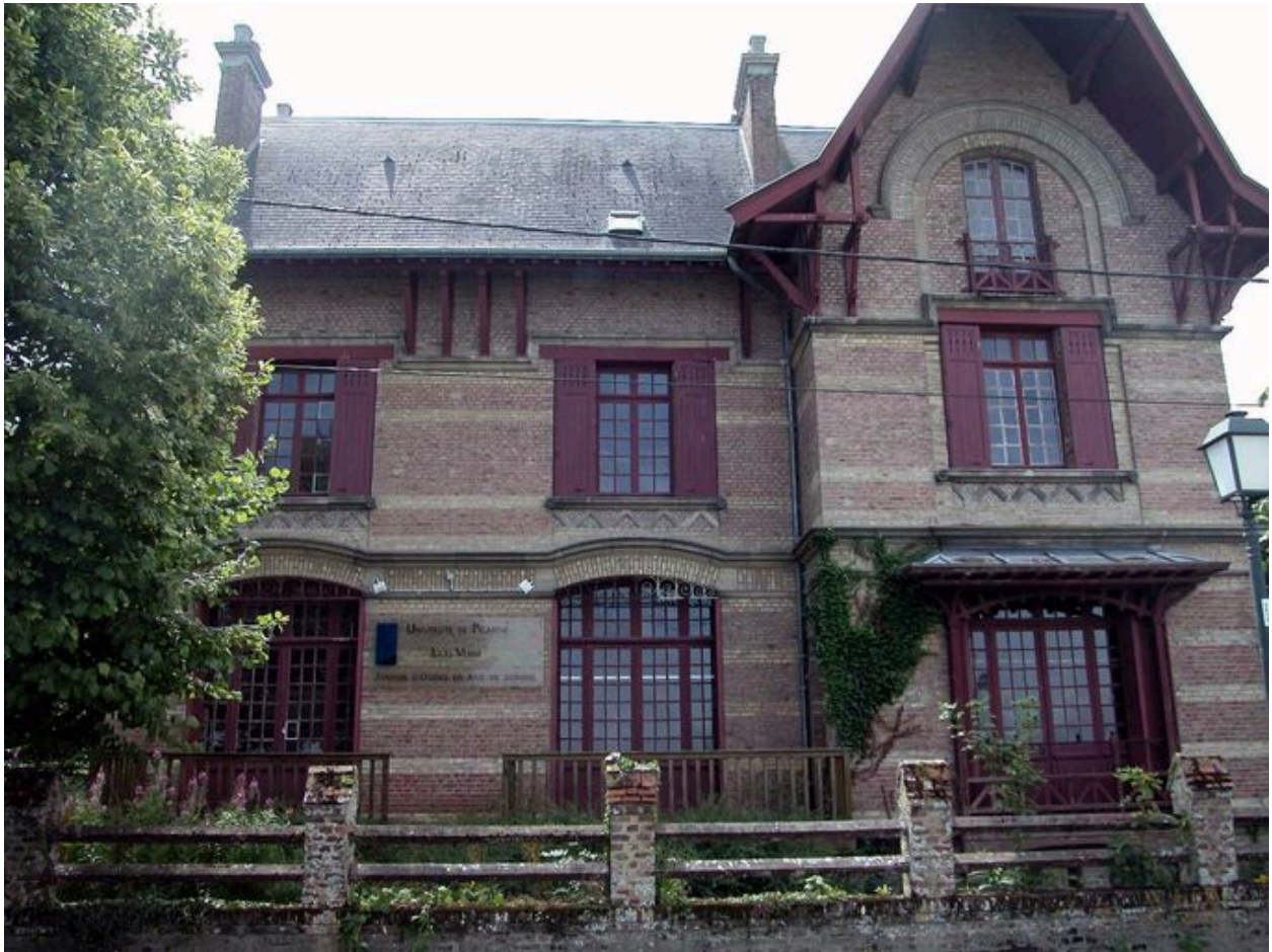
Vue d'ensemble depuis la digue.
