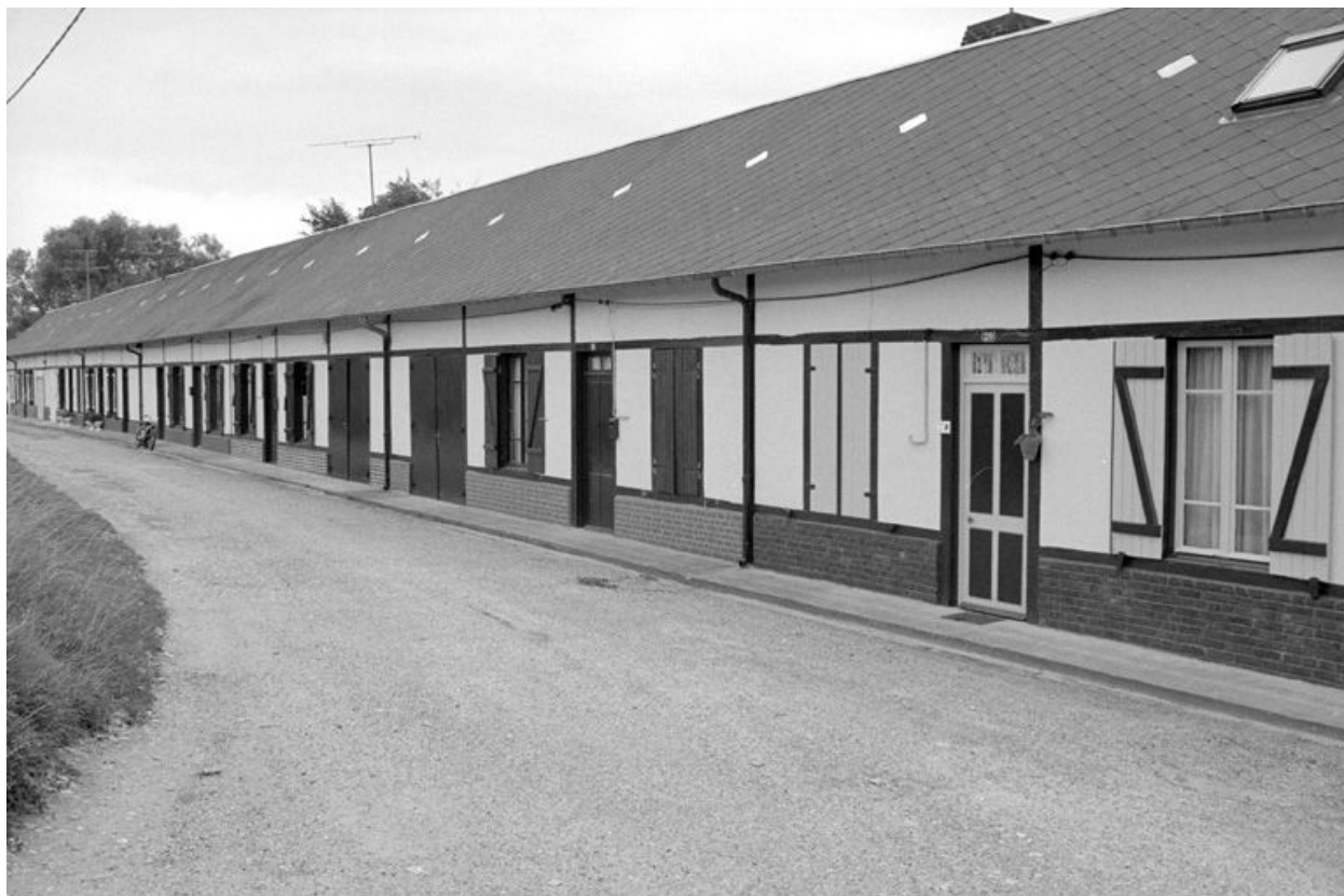
Logements d'ouvriers (cité Rouzelin), vue générale.
