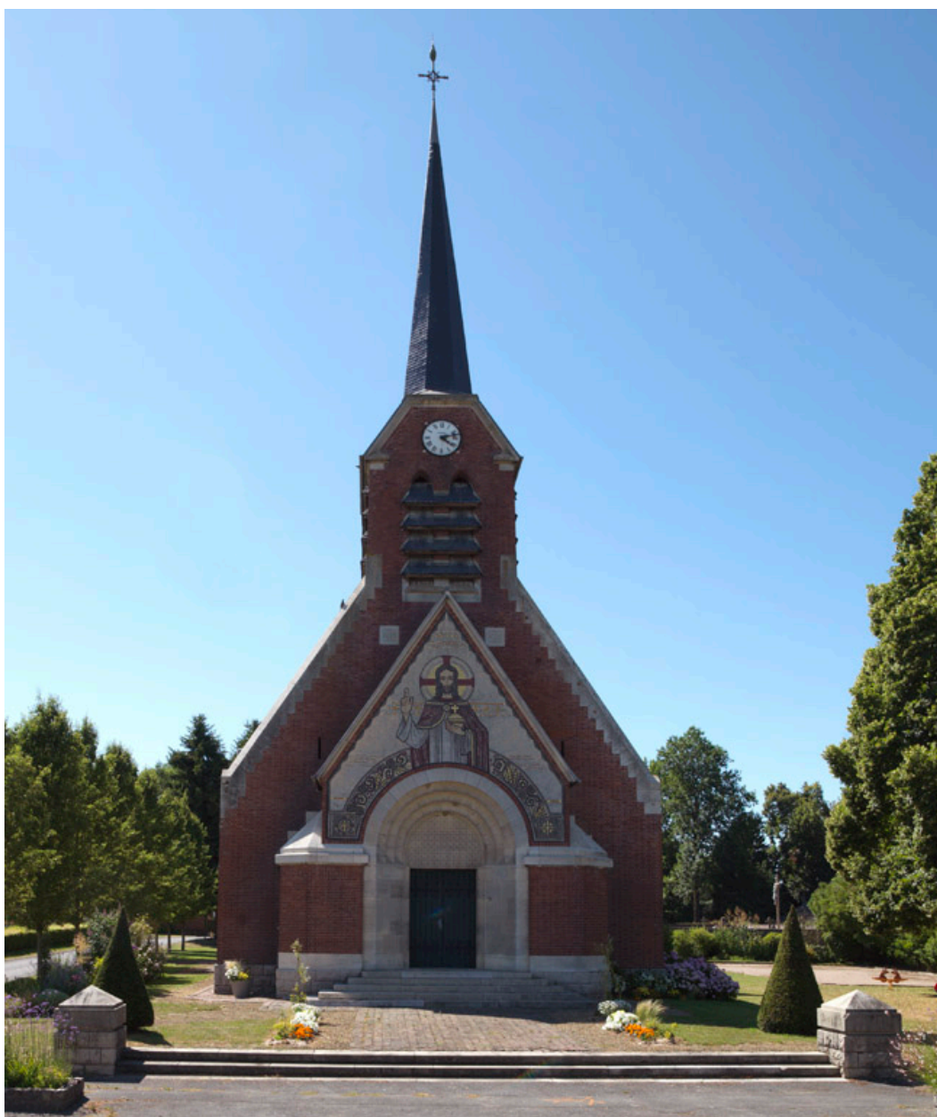
Vue de la façade est.
