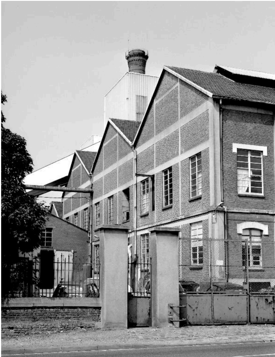
Atelier de fabrication, flanc sud-ouest.
